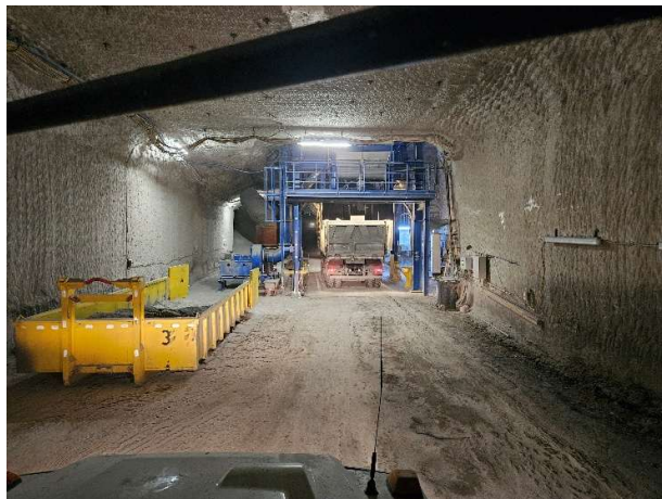
Modtageanlæg i 400 meters dybde
