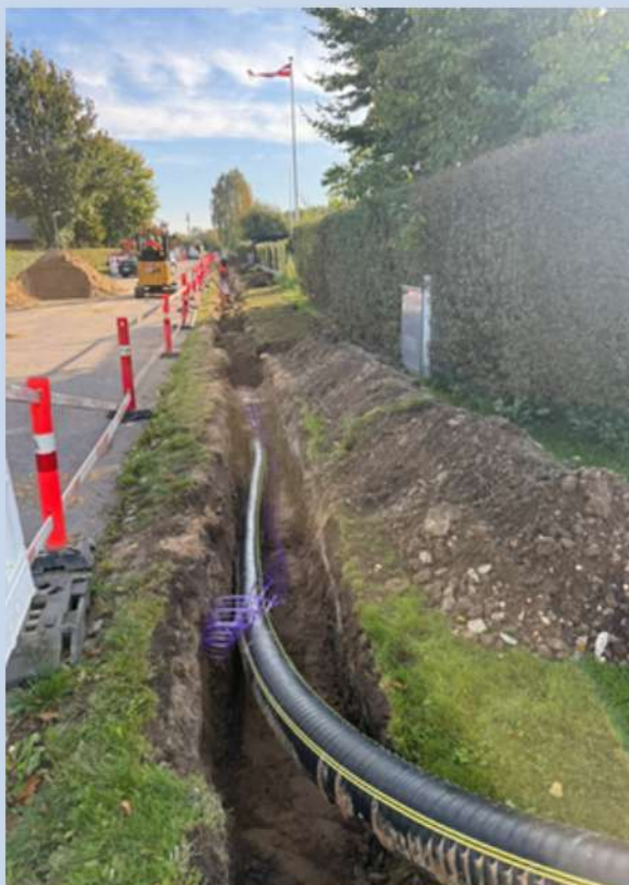
DE NYE PLASTRØR
