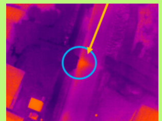
Brud på fjernvarmeledning i offentlig vej
