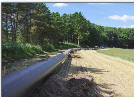
TRANSMISSIONSLEDNING TIL GJERN
